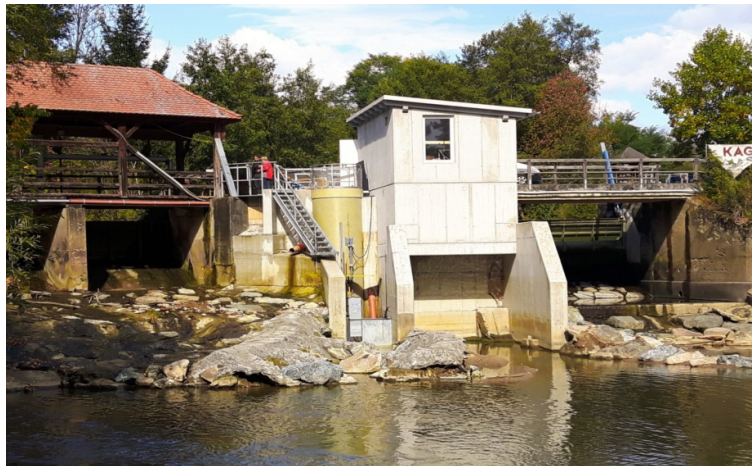
Krafthaus mit Fischliftsystem
