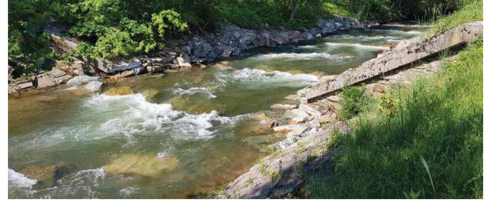
Abb. 5: Aufgelöste Riegelrampe – massiver Sohlabsturz in Gasselsdorf nach Umbau © Günter Parthl
