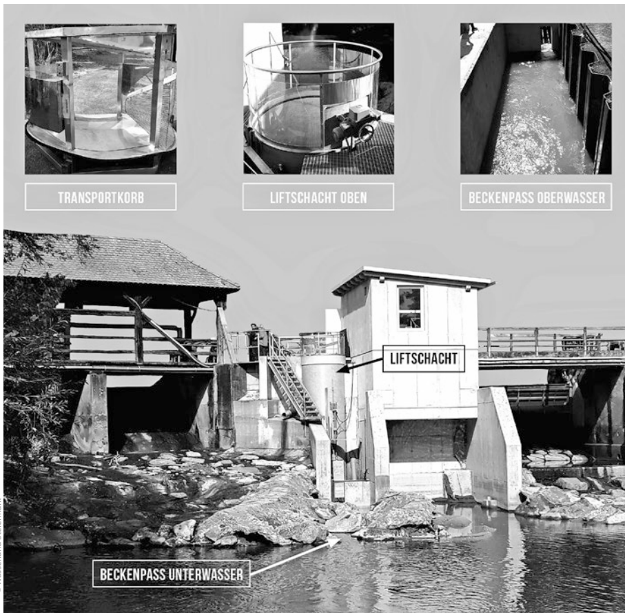
Bild 1: Kombiniertes Fischliftsystem KW Bad Blumau
